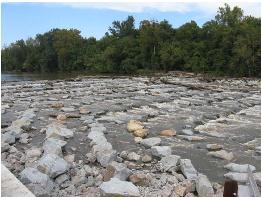
Slika 5.1: Prikaz ribljeg prijelaza odnosno posebno uređenog praga na rijeci
